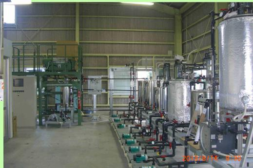
左: 抜気槽、右: 200L発酵槽
