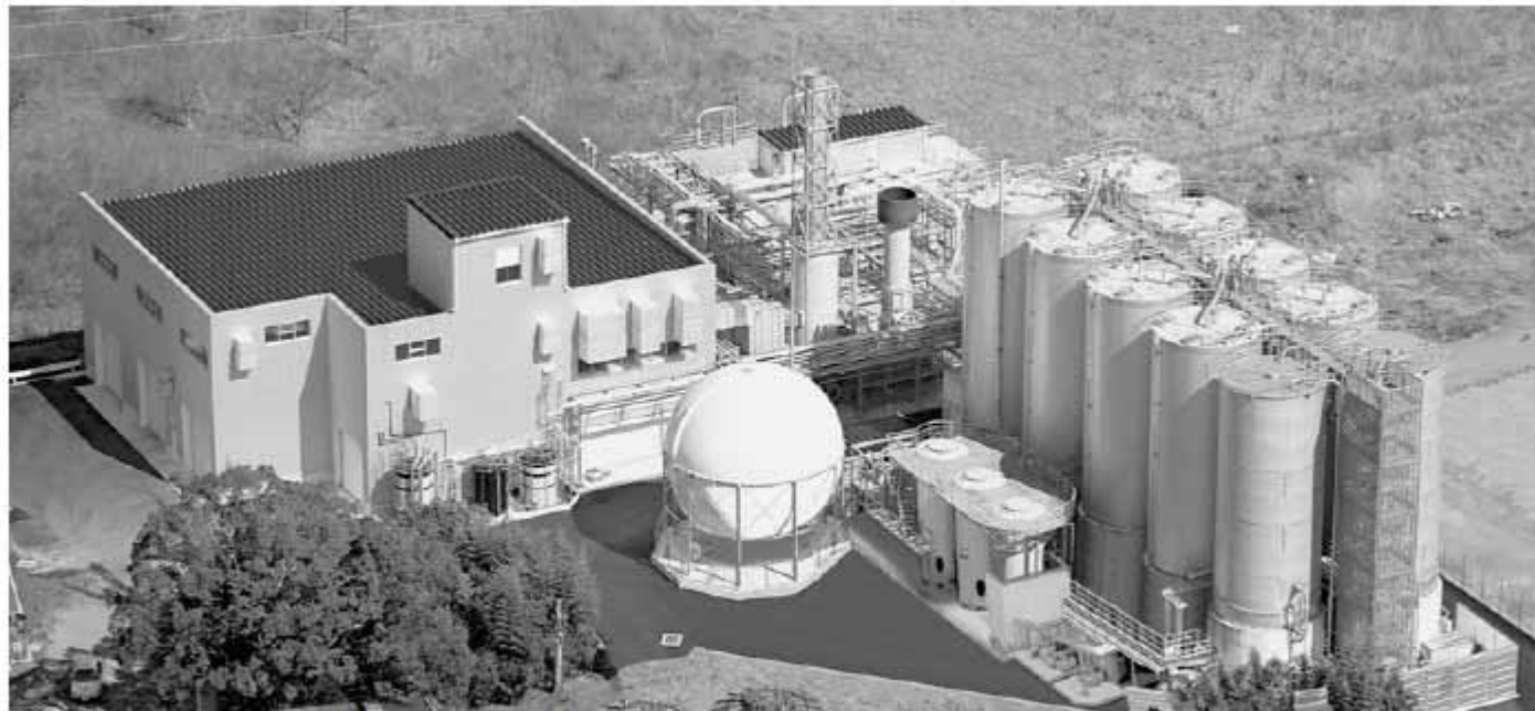
写真-1 霧島酒造焼酎粕リサイクル施設全景
